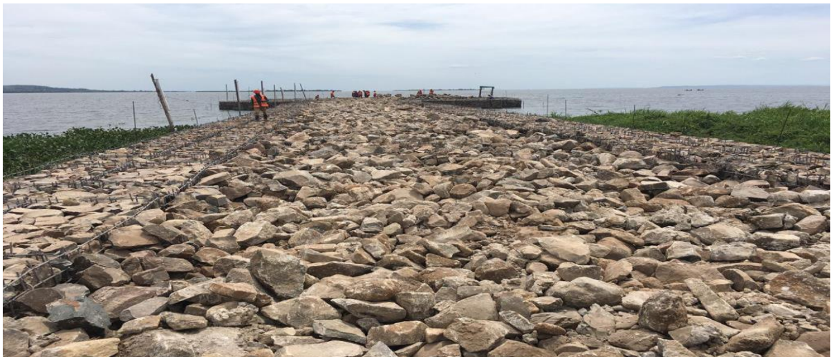
Sehemu ya ujenzi wa gati katika bandari ya Nyamirembe.
