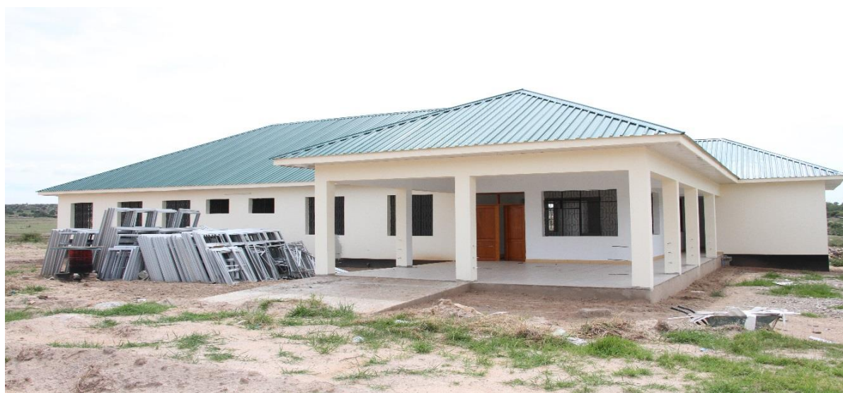
Jengo la mionzi katika hospitali ya Wilaya ya Ilemela.
