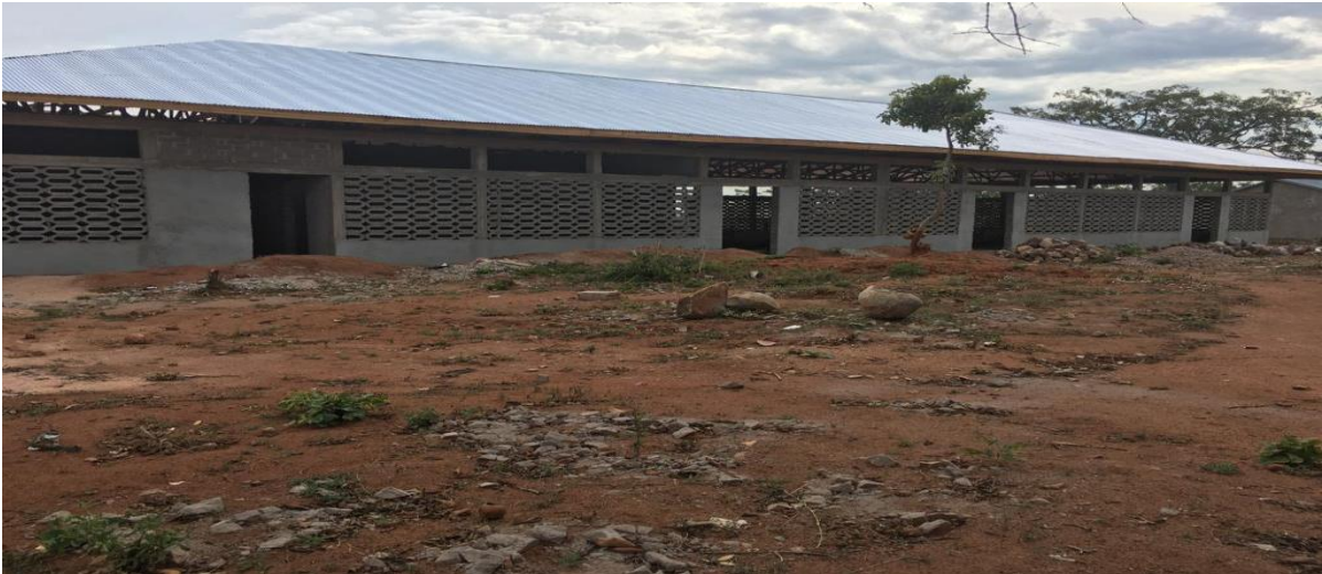
Muonekano wa Bwalo linalojengwa kupitia mradi wa EP4R katika Shule ya Sekondari Bukombe
