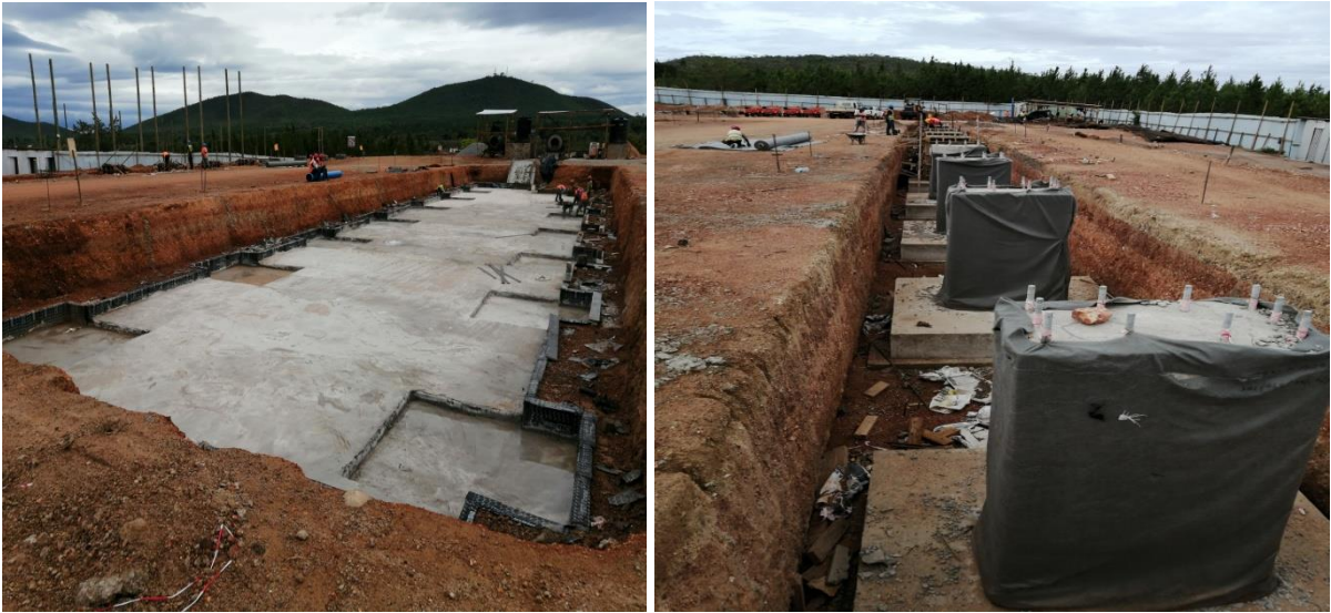
Ujenzi wa Kituo cha kupoza Umeme wa 220/33kV cha Geita
